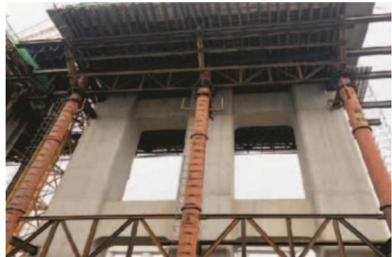
承台支墩支撑
