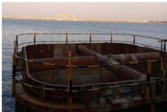
钢吊箱内支撑
