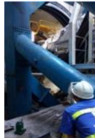
反力架初始值测量
