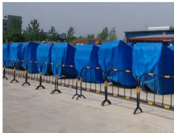
管片隔离防护
