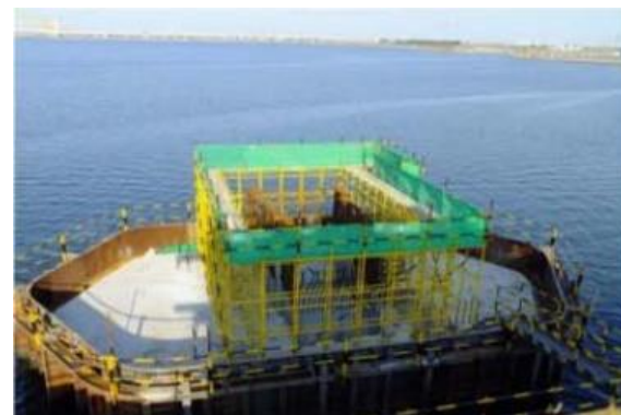
钢吊箱承台施工
