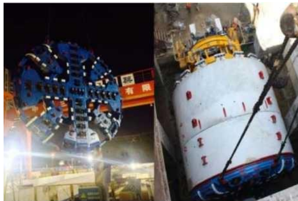
盾构吊装下井
